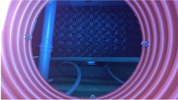
Po demontażu podstawy dmuchawy dostęp do komory osadu czynnego i złoża biologicznego
